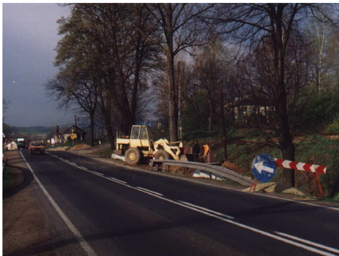
Droga nr 52. Widok w stronę Wadowic (budowany chodnik w 1998r.)
